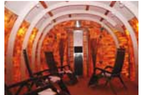
Die moderne „Salzgrotte“ ist mit einer Lüftung versehen, die vom IBEG geplant wurde Bild: Ringhotel Krone in Schnetzenhausen
