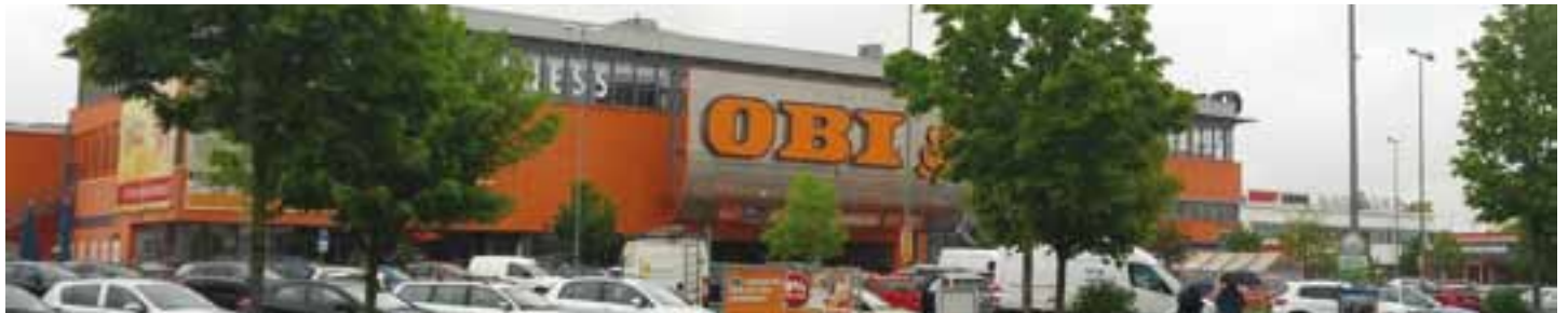
Die Haustechnik des gesamten OBI-Areals wird von der KLIMAWELT gewartet
