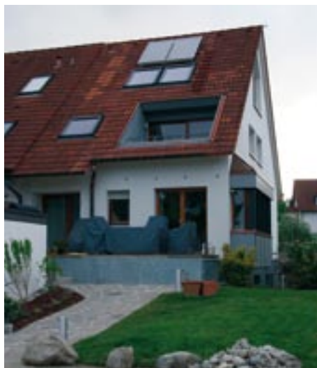
Energetische Sanierung im Eigenheim
